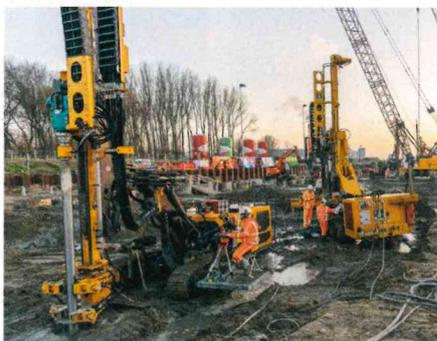
Rund 10.000 Tonnen an GEWI-Material werden durch Bauer angeliefert und als 4.500 Einzelpfähle verbaut
